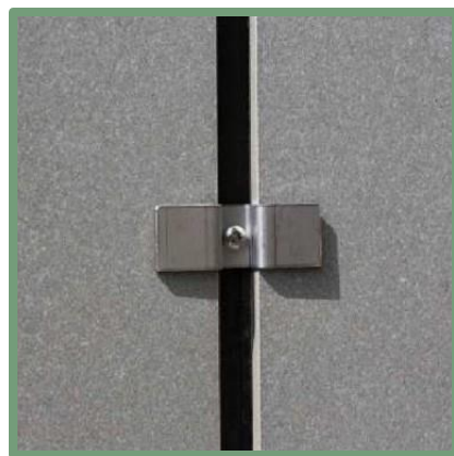
Enkelt beslag for fasademontering som ikke lager hull i plate og dermed øker ombrukspotensiale. Kilde: Vandkunsten Arkitekter
