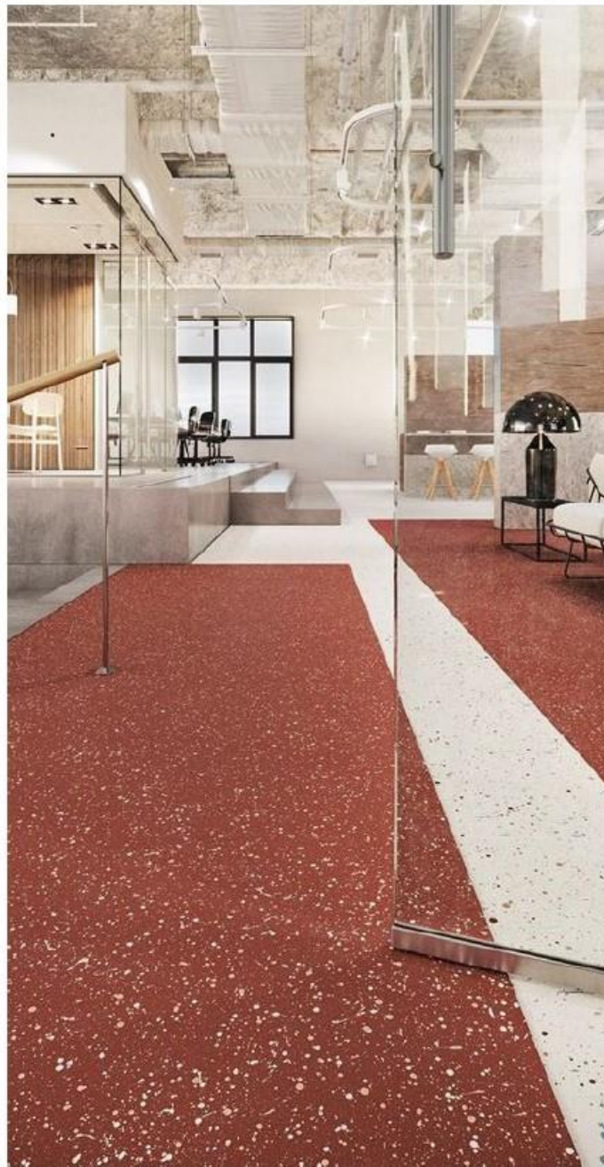
Ombruk av murstein som tilslag og pigment i betong gulvpåstøp, fra riving av eksisterende mursteinstrappehus og -fasade.
