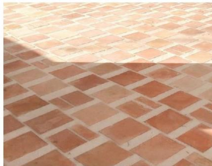
Ombruk av murstein som tilslag og pigment i betong gulvpåstøp, fra riving av eksisterende mursteinstrappehus og -fasade.
