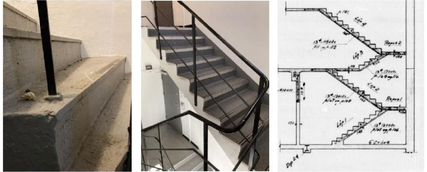
Figur 4 Betongtrapper i Bygg 2 og 3 samt originaltegning fra Den norske Remfabrik i 1929
