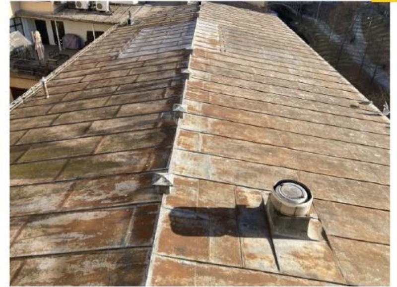
Figur 5 Taktekking med tynnvalsete stålplater. Plateformatet er 780x2700mm, med stangfalsler.
