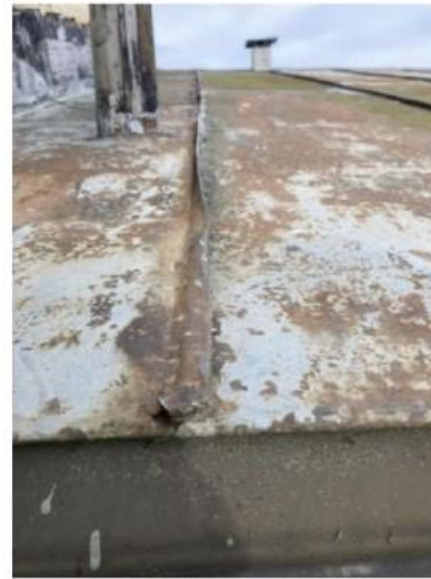
Figur 5 Taktekking med tynnvalsete stålplater. Plateformatet er 780x2700mm, med stangfalsler.
