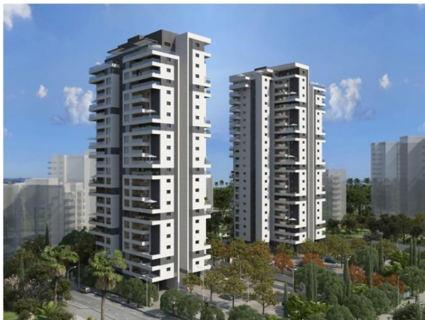
איור 4 - הדמיה של פרויקט חלומות ראש העין, מקור: חברת שיכון ובינוי גדל"ן בע"מ.
