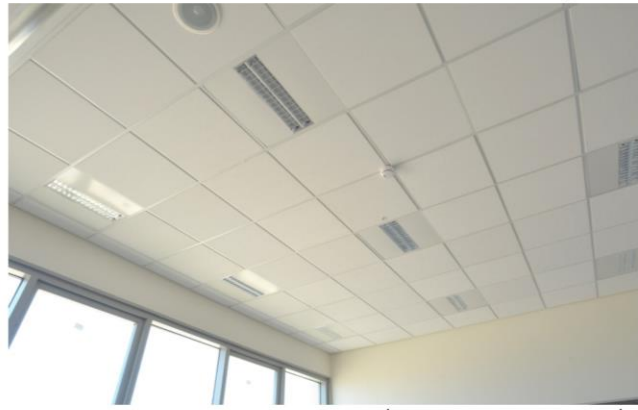
שליטה אוטומטית בתאורה ובמיזוג על ידי חישני נוכחות וחישני תאורה טבעית
